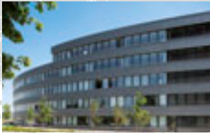
Bürogebäude Sky, Unterföhring, Deutschland
