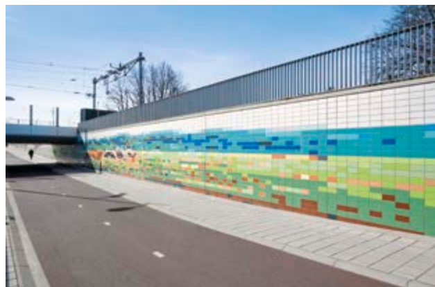
Эффективность в местах особо интенсивного выброса вредных веществ Тоннель «Fedor van Kregtentunnel», Нидерланды / Архитектор: Royal Haskoning DHV, г-н Мари Баау / Фото: Марсель ван дер Бург
