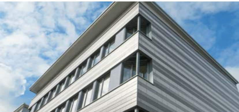
Istituito tecnico Naabtal, Nabburg, Germania / Architetto: Architekturbüro Schönberger / Anno: 2016 / Foto: Atelier Bürger
