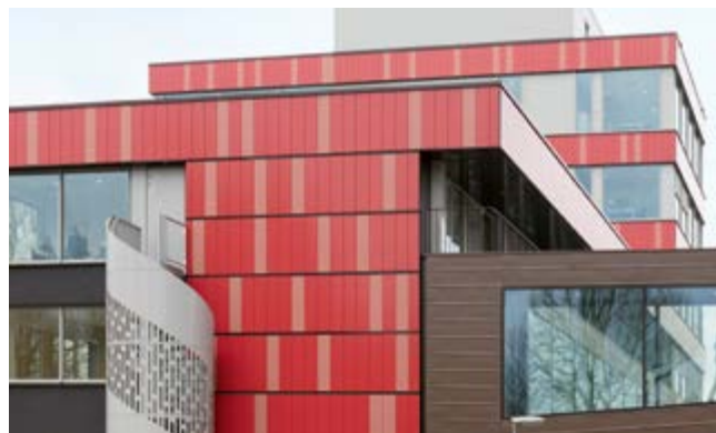
Edificio amministrativo, Groningen, Paesi Bassi / Architetto: SKETS architectuurstudio/ Anno: 2015 / Foto: Marcel van der Burg
