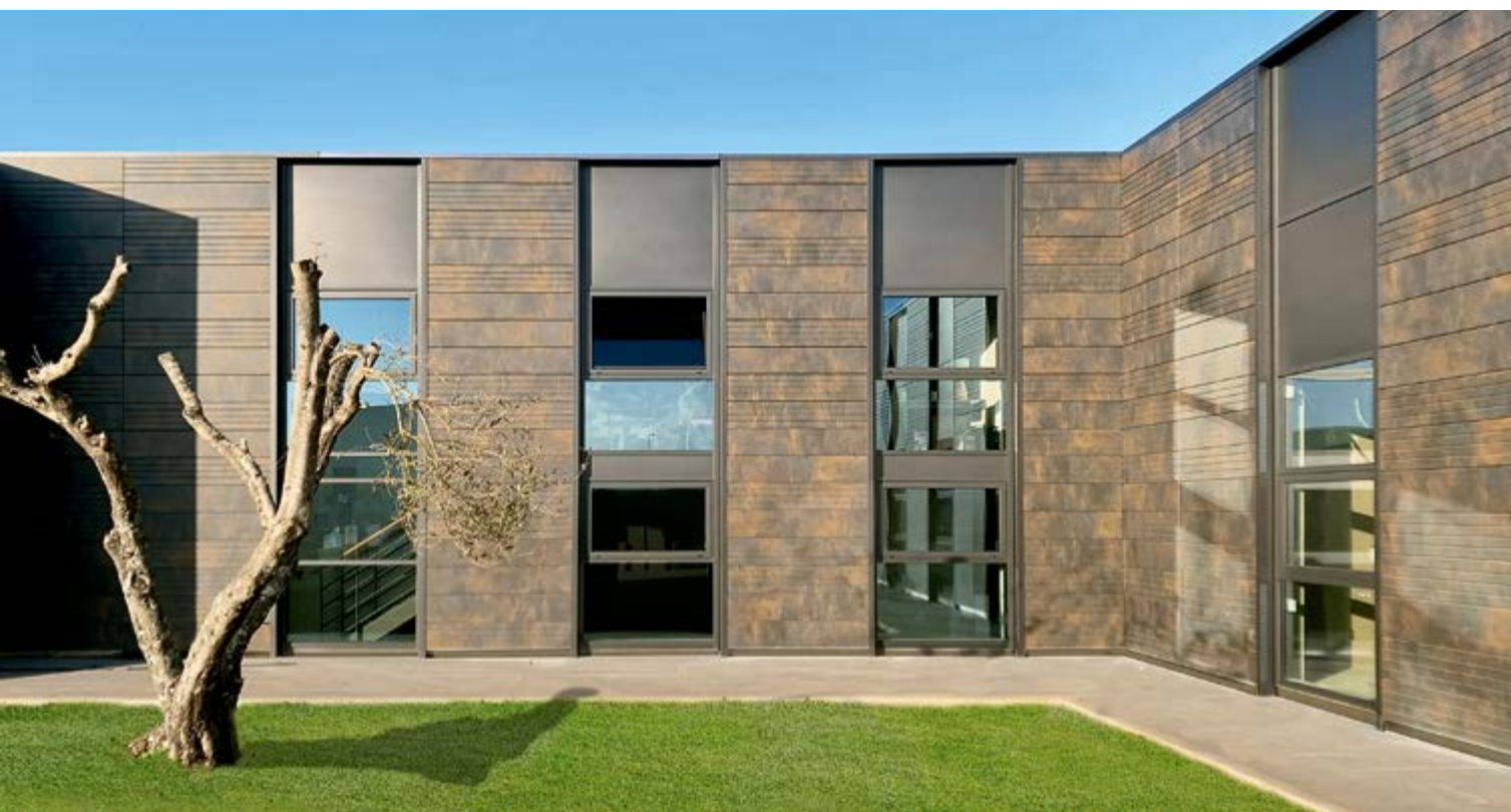
Sede aziendale di CR PROJECT SERVICE S.R.L., Viterbo, Italia / Architetto: NOU SFERA LAB / Anno: 2020 / Foto: Andrea Pietroni, VM Group
