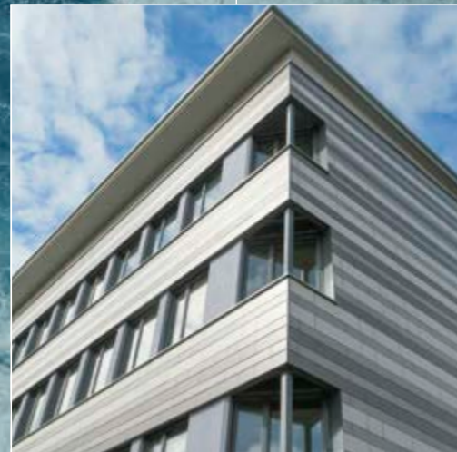
Anti-salissures sur les façades Naabtal-Realschule, Nabburg, Allemagne / Architecte : Schönberger Architects / Photo : Atelier Bürger
