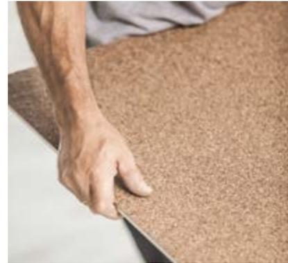
L'option DryTile est disponible pour les carreaux de sol de la série Area Pro, pour la plupart des formats compris entre 30 x 60 cm et 60 x 120 cm. DryTile est une technologie innovante qui permet de revêtir et de poser des carreaux sans avoir recours à la colle.
