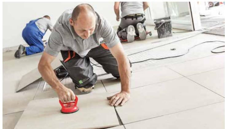
5 DryLile Fliesen sind jederzeit einfach austauschbar. Einfach Fuge aufschneiden, Fliese mit einem Saugheber herausnehmen und neue Fliese einsetzen.
