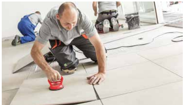
5 Drytile Fliesen sind jederzeit einfach austauschbar. Einfach Fuge aufschneiden, Fliese mit einem Saugheber herausnehmen und neue Fliese einsetzen.
