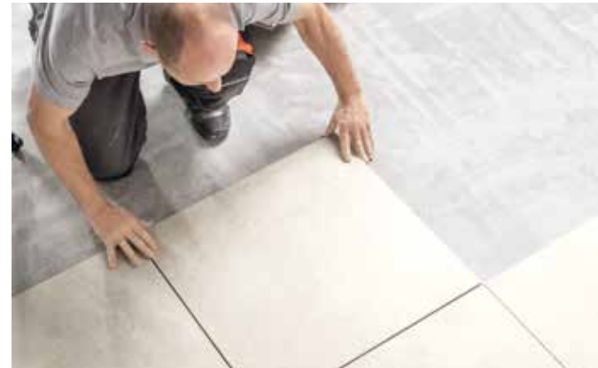
3 Fugenraster festlegen und Korkkanten press aneinander legen.
