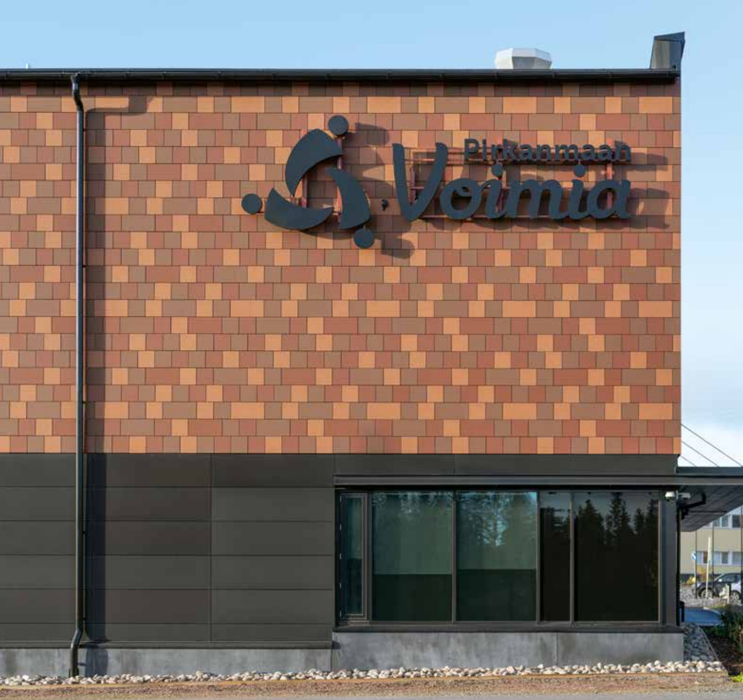
Cocina comercial Voimian Pata, Tampere, Finlandia / Arquitecto: RE-Suunnittelu Oy / Productos: Design sin esmaltar, KeraTwin®, KeraTwin K20®, Natura sin esmaltar / Foto: Nakymat Visuals OY – ABL-Laatat
