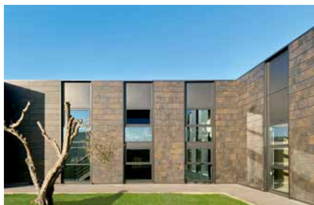
Sede CR PROJECT SERVICE S.R.L., Viterbo Italia Arquitecto: NOU SFERA LAB / Año: 2020 / Foto: Andrea Pietroni, VM Group
