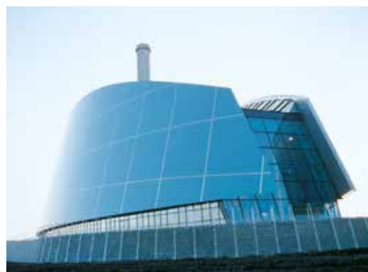
Centrale termica, Viborg, Danimarca / Architetto: Arkitekterne, Peter Kjølgaard & Thomas Pedersen M.A.A, Viborg
