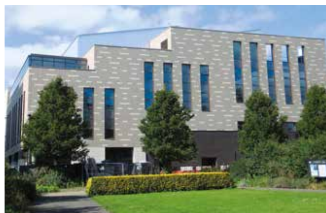
SNAC, Southampton, Gran Bretagna / Architetto: CZWB Architects / Anno: 2015 / Foto: Norbert Lindner
