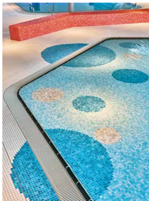
Schwaketenbad, Constance, Allemagne Architecte : Behnisch Architekten, Stuttgart, Allemagne Séries : Système de tête de bassin Wiesbaden, Fresh Photo : David Matthiessen
